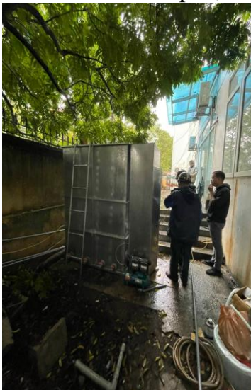
Hình 3.41: Chuyên thiết bị vào vị trí lắp đặt
