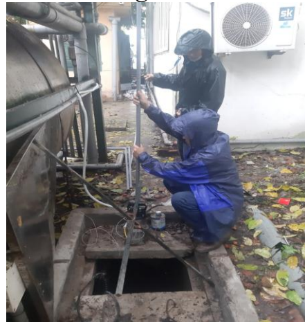
Hình 3.47: Lắp đặt bơm tại bể điều
