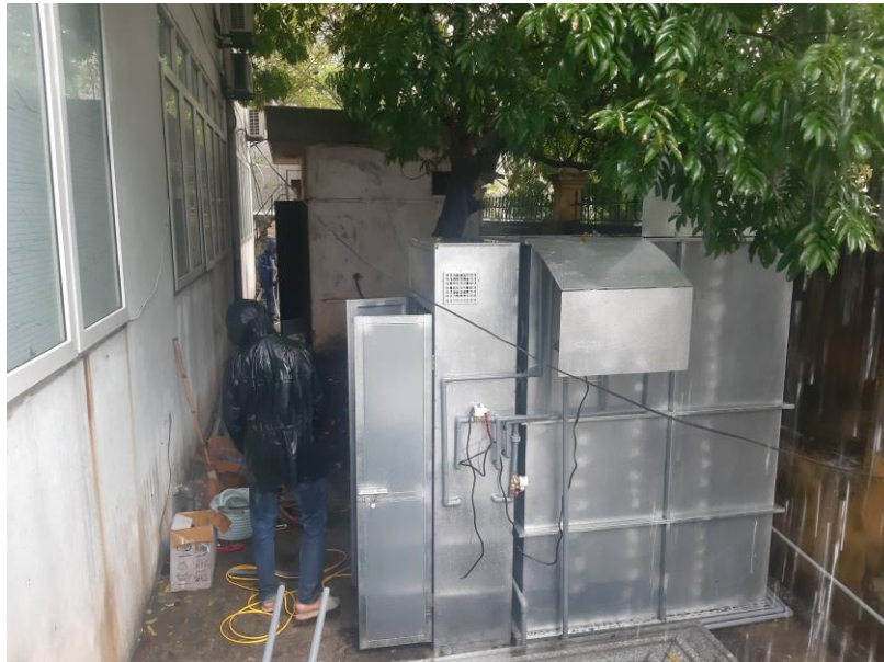
Hình 2.8: Mô hình xử lý nước thải sinh hoạt theo công nghệ MBBR công suất 50 lít/giờ (tương đương 1\text{m}^3 /ngày đêm) tại Bệnh viện Mắt Hưng Yên
