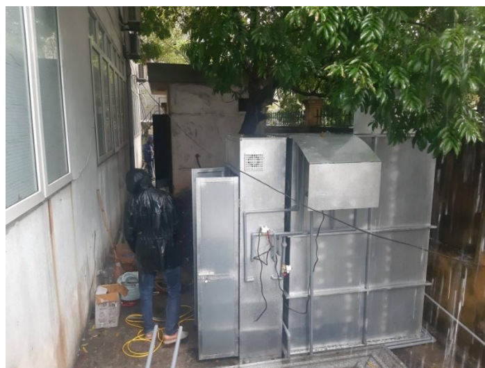
Hình 2.7: Mô hình xử lý nước thải sinh hoạt theo công nghệ MBBR công suất 50 lít/giờ (tương đương 1m 3 /ngày đêm) tại Bệnh viện Mắt Hưng Yên
