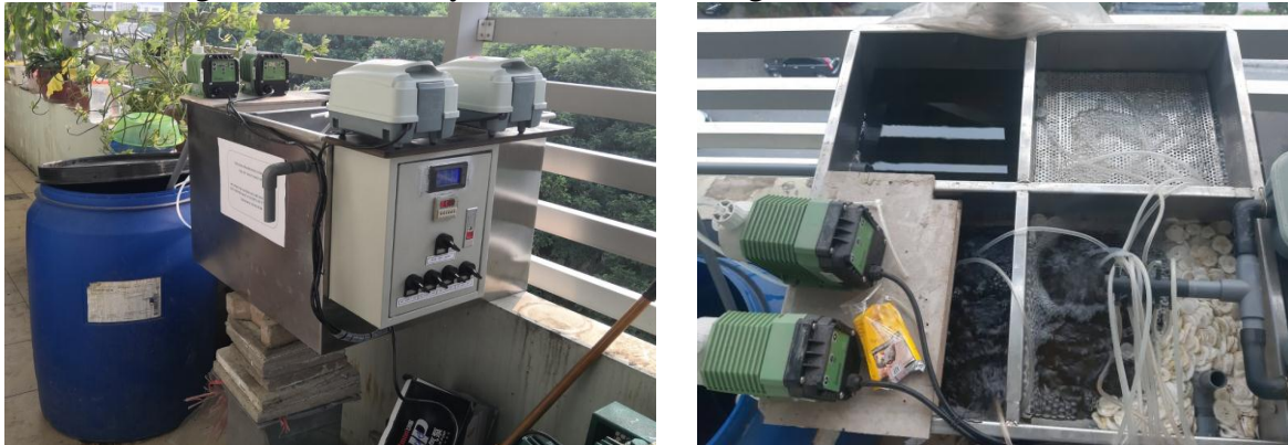
Hình 2.6: Mô hình xử lý nước thải sinh hoạt theo công nghệ MBBR công suất 2 – 10 lít/giờ a. Vận hành mô hình xử lý nước thải sinh hoạt theo công nghệ MBBR với công suất 50 lít/giờ (tương đương 1m 3 /ngày đêm) tại Bệnh viện Mắt Hưng Yên sử dụng giá thể xốp PE.
