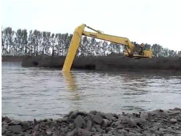
Hình. Sử dụng máy xúc nạo vét kênh mương
