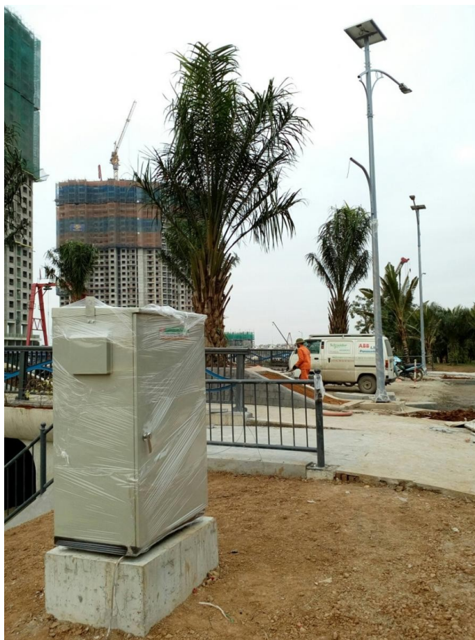
Hình 3.1. Tủ đèn và cột đèn đường sử dụng pin năng lượng mặt trời
