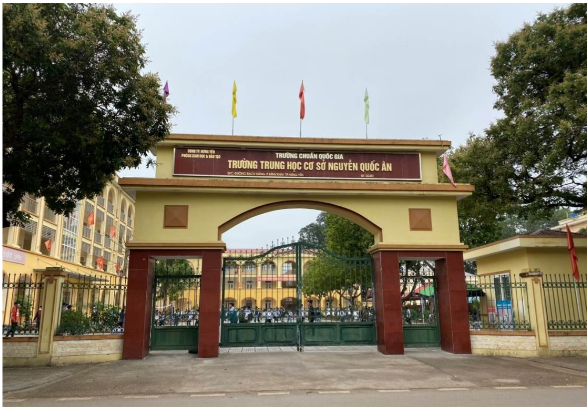
Trường THCS mang tên Nguyễn Quốc Ân tại đường Bạch Đằng, phường Minh Khai, thành phố Hưng Yên
